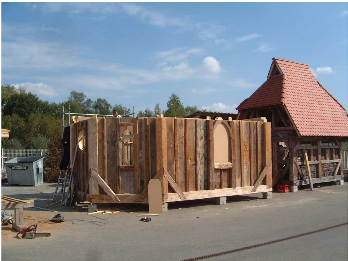
Erdgeschoß, der sich noch im Bau befindlichen Josefskapelle
